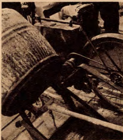
A betonkeverő Dongó-motoros meghajtással
